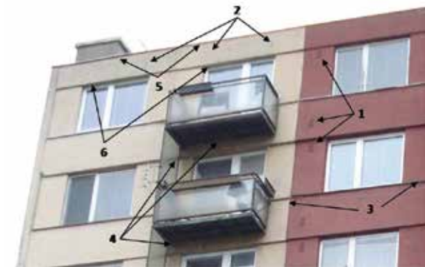
Potenciální úkryty netopýrů na panelovém domě (1 – odvětrávací šachty, 2 – odvětrání střechy, 3 – spáry mezi panely, 4 – štěrby na balkónech, 5 – štěrby za obložení střechy, 6 – štěrby nad okny)
