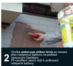
3 Nanášená vrstva omítky weber.pas silikon brick se upraví nerezovým hladítkem do roviny tak, aby její přibližná tloušťka odpovídala tloušťce nalepené papírové šablony.
