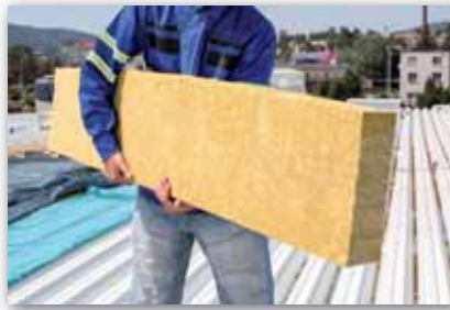
Lamely může vzhledem k rozměru a nízké hmotnosti pokládat jeden pracovník samostatně. Tak dochází také ke zvýšení produktivity pokládky.
