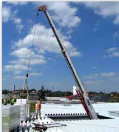
Lamely může vzhledem k rozměru a nízké hmotnosti pokládat jeden pracovník samostatně. Tak dochází také ke zvýšení produktivity pokládky.
