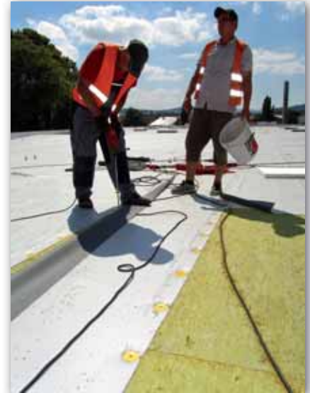
Lamely může vzhledem k rozměru a nízké hmotnosti pokládat jeden pracovník samostatně. Tak dochází také ke zvýšení produktivity pokládky.
