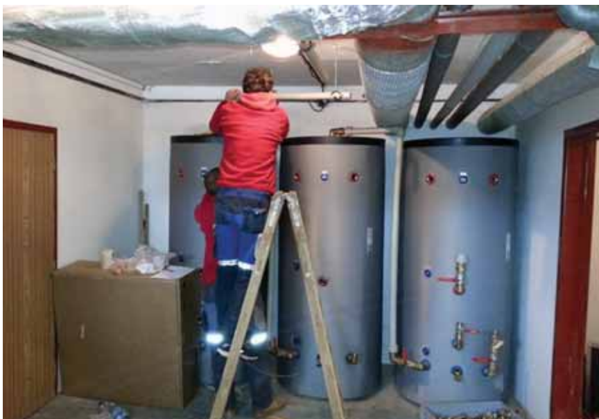
Instalace tepelného čerpadla.
