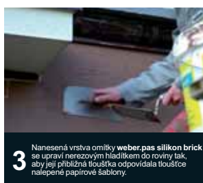
2 Omítka weber.pas silikon brick se nanese přes nalepenou šablonu na podklad nerezovým hladítkem. Při nanášení nesmí dojít k poškození nalepené šablony.
