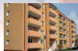
Finální provedení lodžií - barevný nátěr sjednotí celkový vzhled domu
