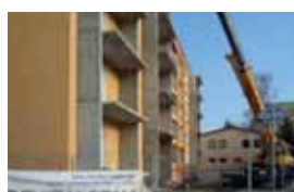
Montáž prefabrikovaných dílů lodžií a jejich ukotvení ocelovými kotvami
