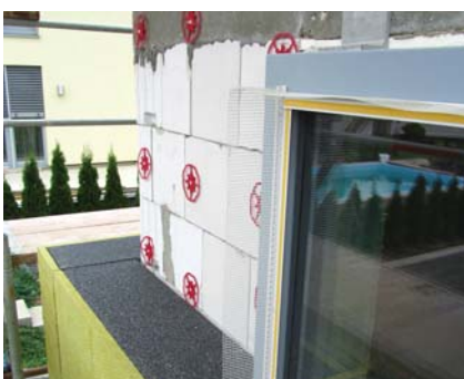
Zateplení deskami Isover TWINNER je možno provádět bez stínění proti slunci.
