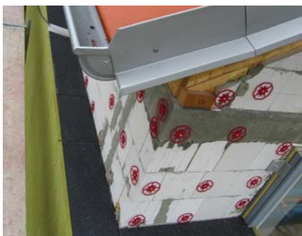
Zateplení deskami Isover TWINNER je možno provádět bez stínění proti slunci.
