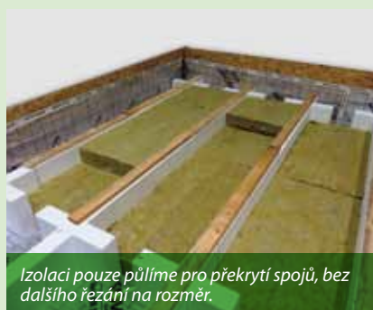
Rošt se sestaví na světlou šířku 595 mm pro ideální vkládání izolace o šířce 600 mm (Isover ORSIK, Isover UNI). Případné nerovnosti vyrovnáme broušením EPS.
