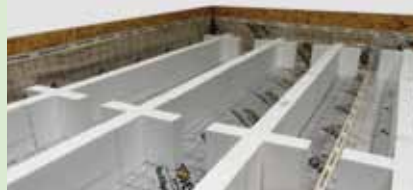
Rošt se sestaví na světlou šířku 595 mm pro ideální vkládání izolace o šířce 600 mm (Isover ORSIK, Isover UNI). Případné nerovnosti vyrovnáme broušením EPS.
