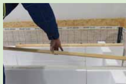
Přilepení prkna šíře 100 mm. Doba zaschnutí spoje je přibližně 1 hodina.
