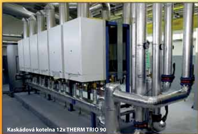
Kaskádová kotelna 12x THERM TRIO 90
