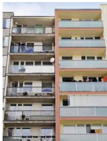
Rozdíl mezi sousedním, dosud neopraveným vchodem, je opravdu nepřehlédnutelný.
