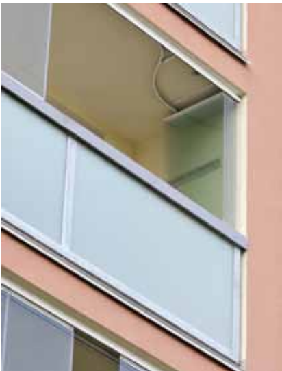
Nové lodžie svou elegantností vhodně do- tvářejí vzhled domu.
