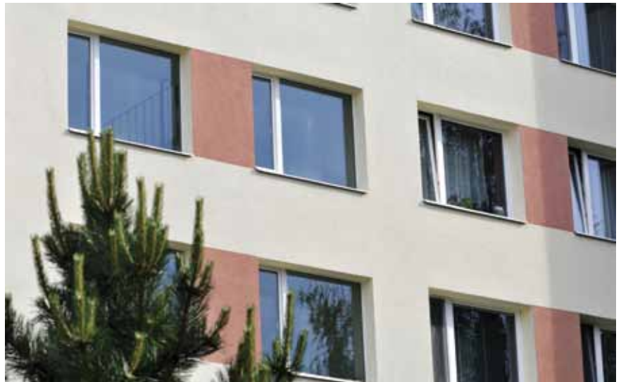
K úsporám energií nejvíce přispívají nová okna a zateplená fasáda se střechem. Po snížení ener- getické náročnosti domu je důležité nezapomenout na revizi otopné soustavy.
